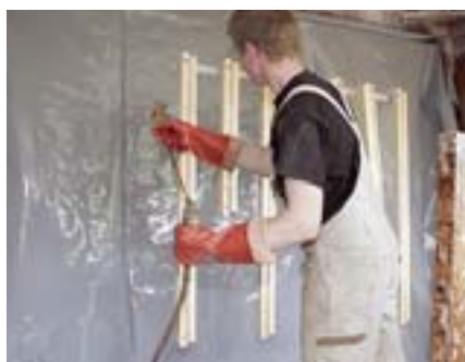
Aufbringen der Schutzgrundierung bequem und handlich auf lose Einzelteile
